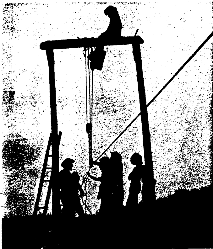
Mittlere Technik in Ces: Für Materialtransporte bauten sich die Ces-Leute eine einfache Seilbahn, die sich als sehr nützlich erwiesen hat.
